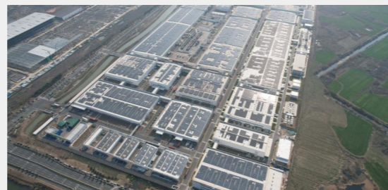
金坛光伏项目
